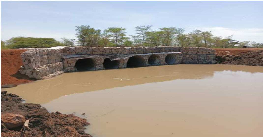
Osudan-Abarilela swamp crossing works (Katakwi/Amuria)
